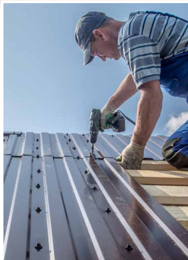
圖 3：外露扣件金屬屋頂系統的安裝
